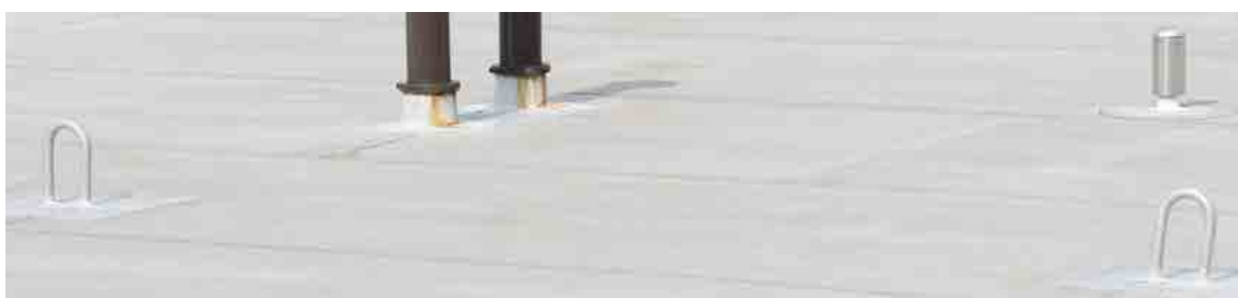
Efektom końcowym jest elastyczna i estetyczna powłoka hydroizolacyjna
