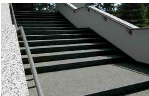
Schody w pieszym ciągu komunikacyjnym
