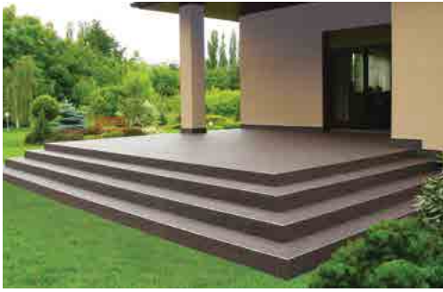
Taras domu jednorodzinnego
