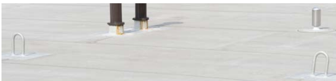
Efektem końcowym jest szczelna i estetyczna powłoka hydroizolacyjna
