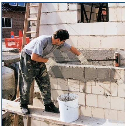
5 Uszczelnienie strefy wody rozpryskowej i/lub okładziny klinkierowej
