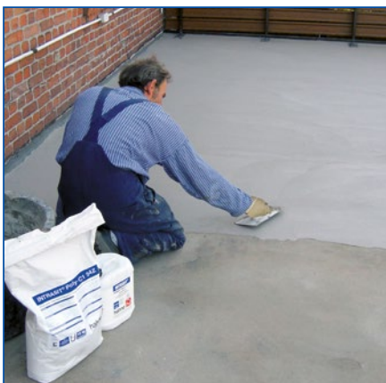
4 Alternatywne uszczelnienie balkonu i tarasu
