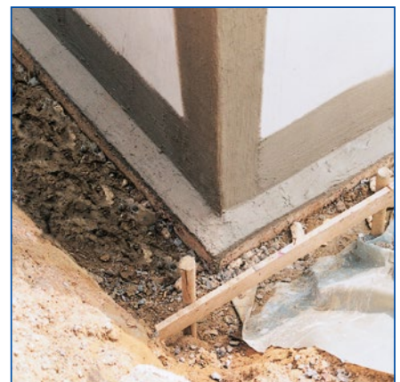
6 Uszczelnienie betonowych elementów budowli
