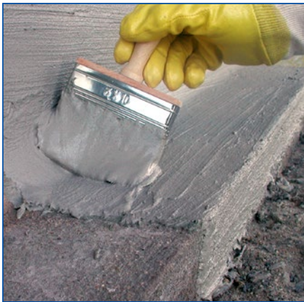
1 Uszczelnienie pośrednie w obrębie styku ściany z płytą betonową
