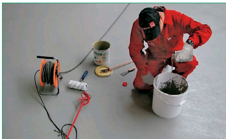
Mieszanie materiału do wykonywania powłok na posadzkach przemysłowych
