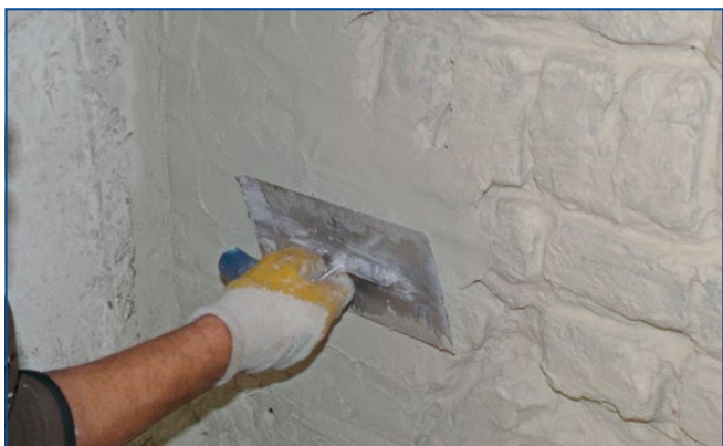
Nakładanie lekkiego tynku klimatycznego INTRASIT® RZ 2 55HSP
