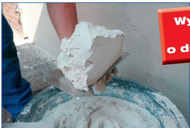
Nakładanie lekkiego tynku klimatycznego INTRASIT® RZ 2 55HSP
