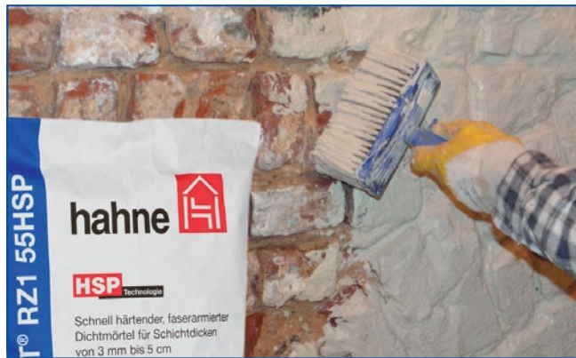
Uszczelnianie powierzchni materiałem INTRASIT® RZ 1 55HSP o konsystencji mikrozaprawy lub zaprawy uszczelniającej pod następującą po niej obrzutkę tynkarską
