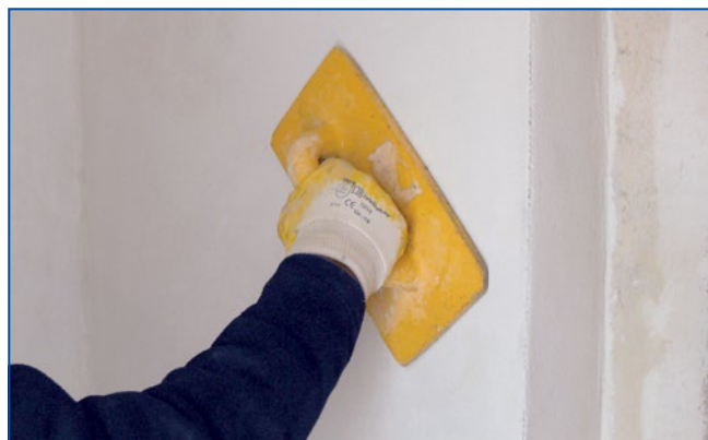
Zacieranie powierzchni wykonanej z INTRASIT® RZ 2 55HSP
