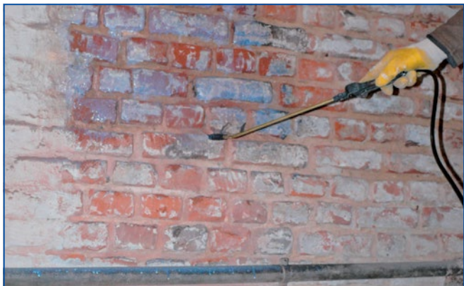
Po dokładnym przygotowaniu podłoża gruntuje się je materiałem INTRASIT® Aquarol 10A
