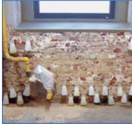
5 Wywiercone otwory wstępnie zwilżyć. Preparat INTRASIT® VK 10A lub INTRASIT® MEK 18OS /- BLK 18OS wprowadzić przez wywiercone otwory do przekroju poprzecznego ściany. Po zakończeniu prac iniekcyjnych napłynąć wywiercone otwory preparatem INTRASIT® BLS 54TR .
