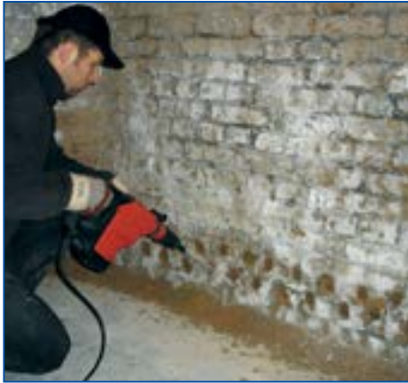
4 Rozmieszczenie wierconych otworów w odstępach 10-12,5 cm. Średnicę wierconych otworów dopasowuje się do stosowanej metody.
