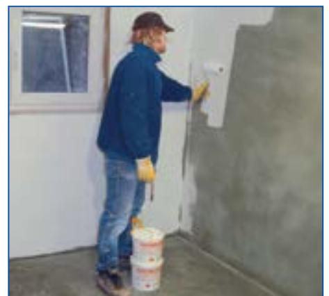
9 Końcowa (wykończeniowa) powłoka powierzchni pokrytej tynkiem renowacyjnym może być wykonywana wyłącznie materiałami paroprzepuszczalnymi. Jako powłokę malarską stosować VESTEROL® SF 10A .
