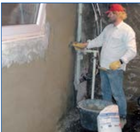
7 Następujące później tynkowanie powierzchni ścian tynkiem renowacyjnym INTRASIT® SAP-WTA 54Z w kolorze szarym/białym lub SanUno WTA 54Z wykonuje się zgodnie z zasadami techniki tynkowania dwuwarstwowo do 20 mm.
