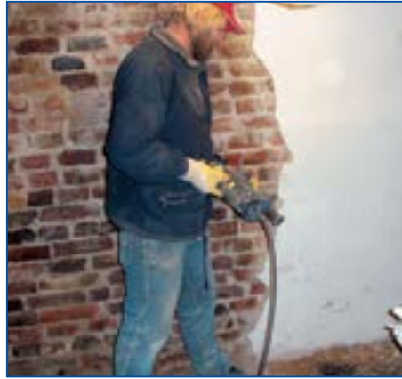
2 Zasolony tynk całkowicie usunąć. Niezwiązaną z podłożem zaprawę spoinującą wyskrobać.
