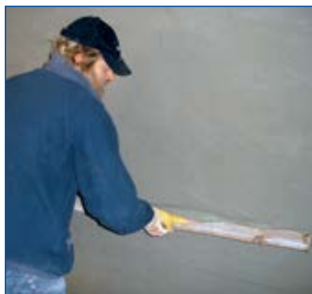
8 Przy większych grubościach tynku lub w przypadku mocno spękanego muru można alternatywnie nakładać INTRASIT® SanUno WTA 54Z , jednowarstwowo, do uzyskania całkowitej grubości tynku 30 mm.
