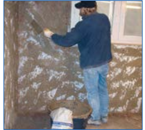
6 W obszarze zawilgoconym (lub na całej powierzchni) dwukrotnie nałóż na przemian mikrozaprawę uszczelniającą INTRASIT® DS2 54Z/- DS1 54Z i INTRASIT® VK 10A . Następnie przez natrysk w formie siatki pokrywającej powierzchnię nałóż zwiększającą przyczepność warstwę obrzutki tynkarskiej z INTRASIT® VS WTA 54 Z .
