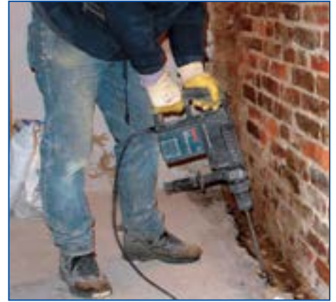
3 Jastrych na styku ze ścianą usunąć na szerokość 30 cm.
