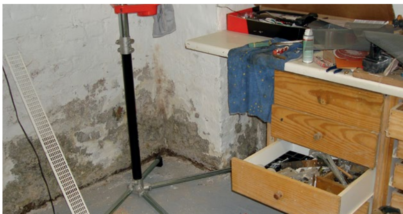
Brakująca cyrkulacja powietrza za elementami wyposażenia mieszkania
