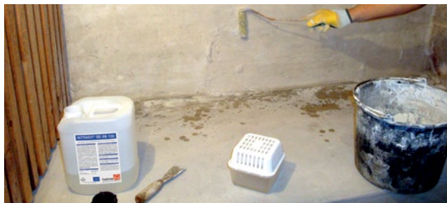
Wstępne przygotowanie podłoża do związania zarodników preparatem INTRASIT® SE-SB 10D
