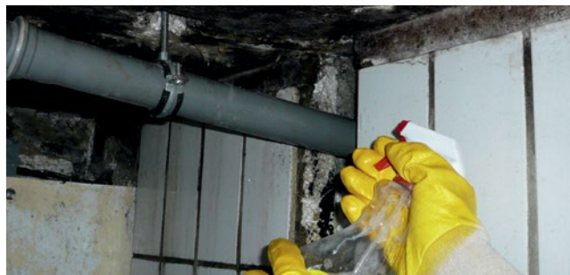
Zwalczanie pleśni preparatami z INTRASIT® SE-SL 18DD w trudno dostępnym miejscu za pomocą opryskiwacza
