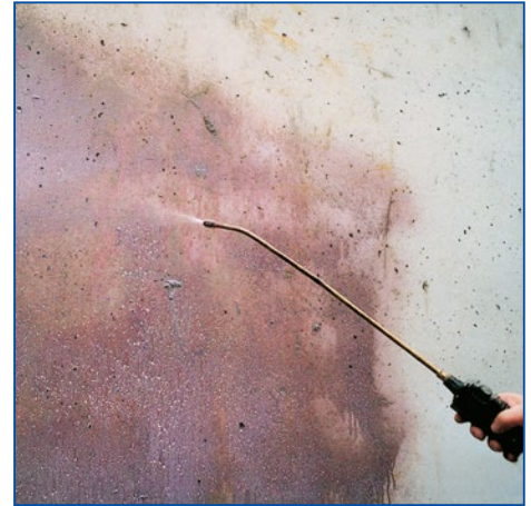
3 Zagruntować chłonne podłoże mineralne materiałem IMBERAL® Aquarol 10D .
