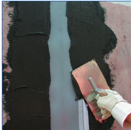
5 Zamknąć szczeliny dylatacyjne taśmą dylatacyjną IMBERAL® FAB 89 ZH .
