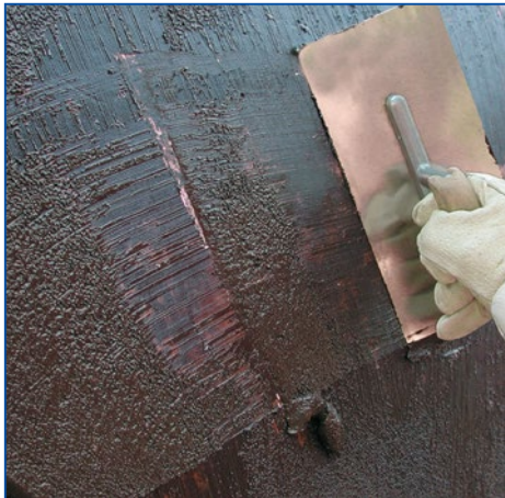
4 Wykonać szpachlowanie drapane w celu zamknięcia otwartych i wyprofilowanych powierzchni oraz porów w betonie.
