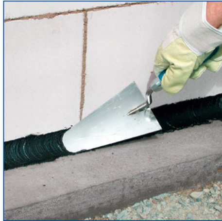
2 Materiałem INTRASIT® S100 90B wykonać wyoblenie na styku powierzchni pionowej i poziomej. Alternatywnie można zastosować INTRASIT® FSM 55Z lub INTRASIT® RZ1 55HSP (wodoszczelna zaprawa naprawcza).
