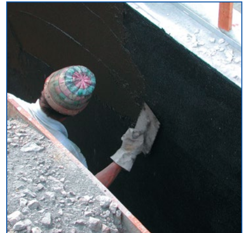
6 Nałożyć warstwę IMBERAL® S100 90B o zamierzonej grubości.
