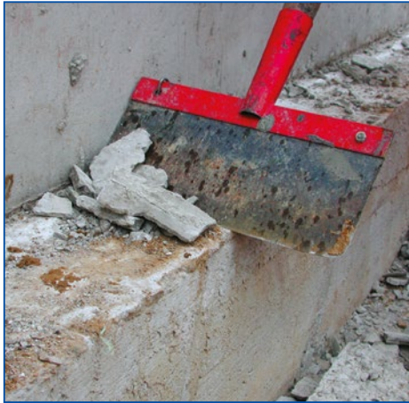
1 Dokładnie oczyścić podłoże i usunąć z niego spieczone warstwy
