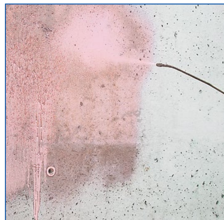
3 Zagruntować podłoże materiałem IMBERAL® Aquarol Winter 16D .
