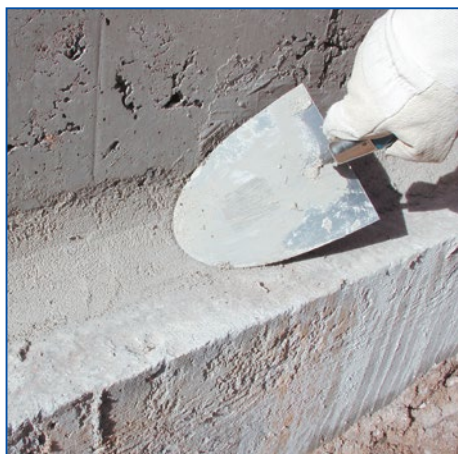
2 Materiałem INTRASIT® FSM Winter 56Z wykonać wyoblenie na styku powierzchni pionowej i poziomej o promieniu ok. 5 cm. Tym samym materiałem wypełnić wyłomy w murze i spoiny z brakującym wypełnieniem (> 5 mm).
