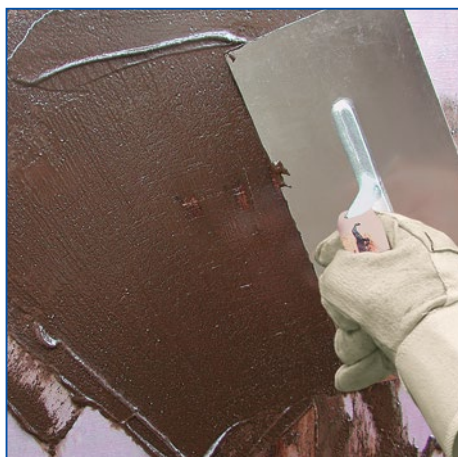
5 Wykonać szpachlowanie drapane materiałem IMBERAL® 2K Winter 26B w celu zamknięcia otwartych, profilowanych powierzchni i porów w betonie.
