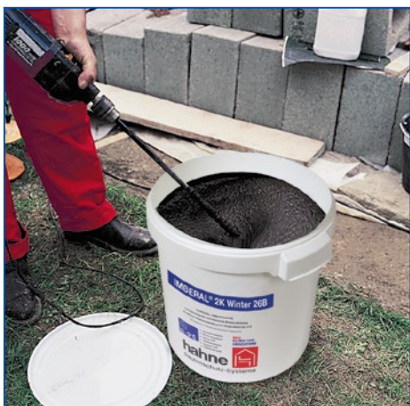
4 Wymieszać IMBERAL® 2K Winter 26B przy pomocy wolnoobrotowej wiertarki z mieszadłem.
