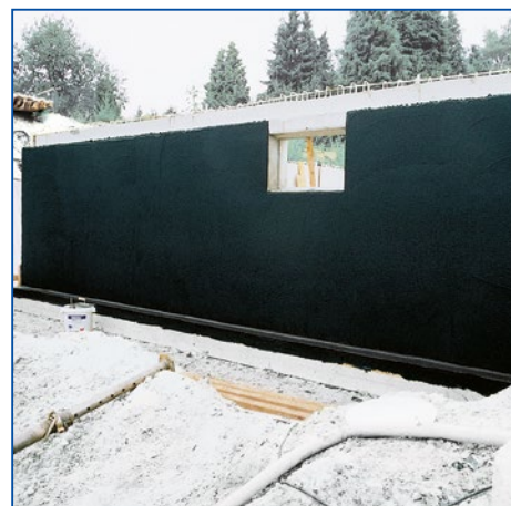
6 Gotowe i pewne uszczelnienie materiałem IMBERAL® 2K Winter 26 B .
