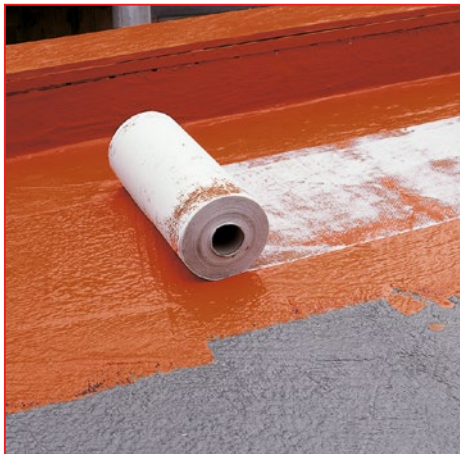
3 W strefach zagrożonych powstawaniem rys i na dachach, na których tworzą się kałuże, konieczne jest położenie dwóch warstw. W 1. warstwę wtapiana jest wkładka wzmacniająca DAKORIT® DV110 89V .
