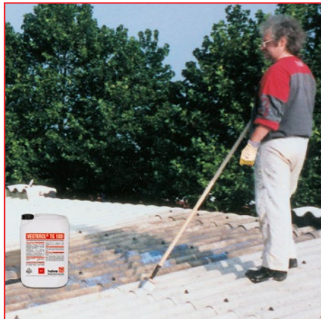
1 Powierzchnie pyłące, beton i cement włóknisty zagruntować materiałem VESTEROL®TG 10D .
