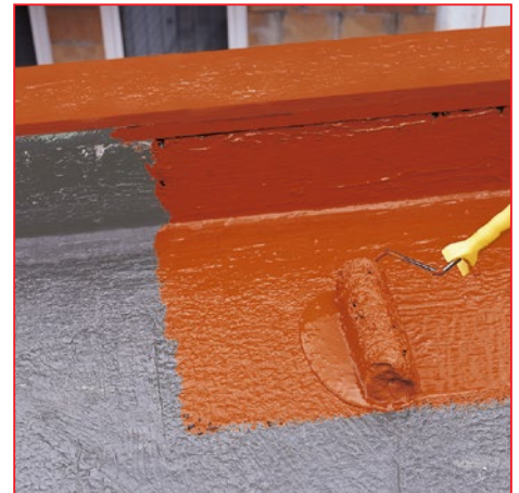
2 Nakładanie powłoki odbywa się bez rozcieńczania przy użyciu wałka, pędzla, ławkowca lub przez natrysk bezpowietrzny.
