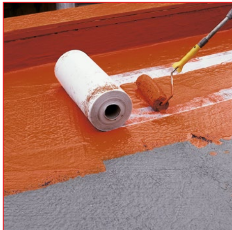
4 Ułożyć DAKORIT® DV110 89V i dobrze pokryć warstwą materiału uszczelniającego.
