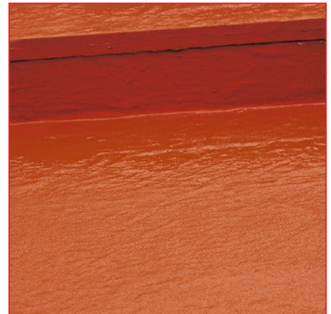
5 Gotowe uszczelnienie dachu preparatem DAKORIT® Ruflex 20D .
