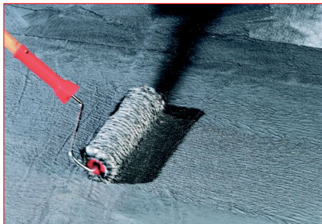
Nałożyć warstwę wykończeniową
