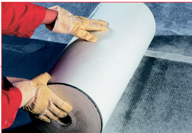
Wtopić włókninę dachową
