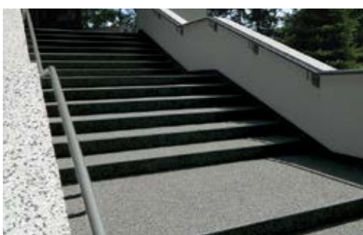
Schody w pieszym ciągu komunikacyjnym
