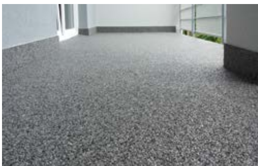
Balkon w bloku mieszkalnym
