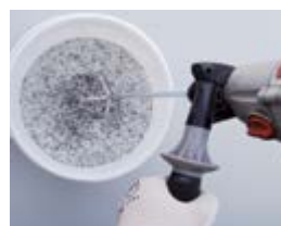
3. Dokładnie wymieszaj spoiwo z kamieniami.
