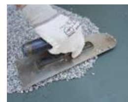
4. Rozprowadź kamienie na przygotowaną wcześniej izolację PROFLEX MST .
